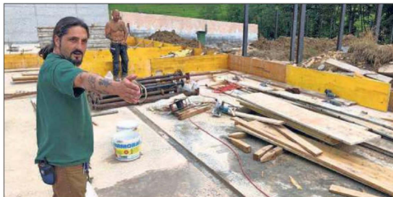
Marc Zihlmann présente le chantier de construction de l'un des enclos à tigre.
